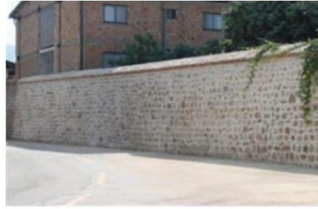
شکل ۸: دیوار غربی باغ چهلستون
