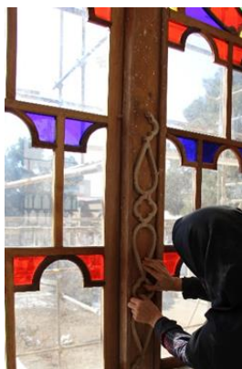
تصویر ۱۸- نصب آلت ها در چهارچوب اصلی
