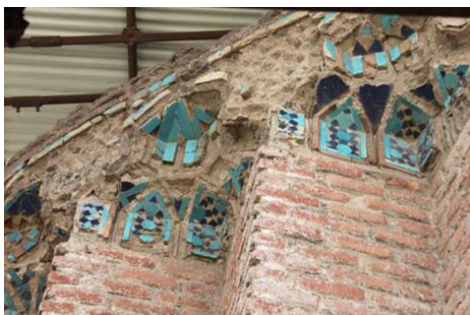
شکل ۱۲: کاشی‌کاری ساقه گنبد، (منبع: نگارندگان، ۱۳۹۶)
