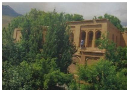
شکل ۴: درختان حیاط در قسمت جنوب بنا
