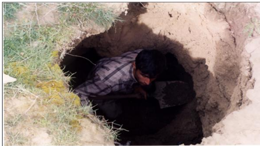
تصویر ۷- تصویر بالایی از فرسایش پای تونلی در منطقه شور دره (زندمقدم، ۱۳۸۶)
