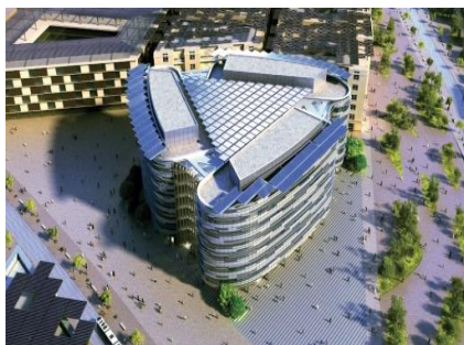
شکل ۱۴- مرکز جهانی IRENA، با بازشوهای متحرک و صفحات فوتولتایک بر روی بام (cibsejournal, 2019)
