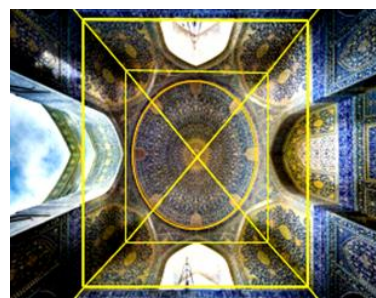
شکل ۵- تصویری از درون گنبد مأخذ: مسجد شاه که در آن فورم مربع در ارتفاع به دایره منتهی شده (مأخذ: rasekhoon.net، تحلیل: نگارندگان) شکل ۶- نقشه قرارگیری گنبد بر روی چهار ستون که از زیر گنبد و بالای گنبد به یک شکل مشاهده می شود. مأخذ: نگارندگان
