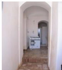
شکل ۱۹- بعد از اجرای فضای سرویس بهداشتی (مأخذ: نگارنده)
