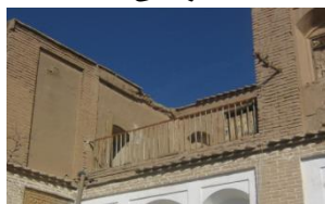
شکل ۲۰- قبل از اجرای دیوار مشبک آجری (مأخذ: آرشیو عکس میراث فرهنگی)
