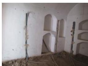
شکل ۱۶- قبل از مرمت اندود دیوار و کف (مأخذ: آرشیو عکس میراث فرهنگی)
