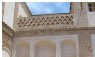
شکل ۲۱- بعد از اجرای دیوار مشبک آجری (مأخذ: نگارنده)
