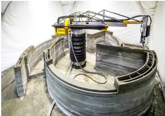
عکس ۱- فرآیند چاپ ارائه شده در فوریه ۲۰۱۷ در شهر استوپینو با چاپگر سه بعدی ساخت و ساز (Apis cor, 2018)
