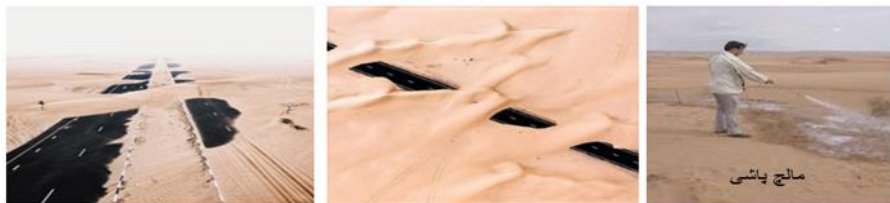
تصویر شماره ۱۷ - تثبیت ماسه های روان با مالچ رسی و آهکی - (منبع arge.blogfa.com )
