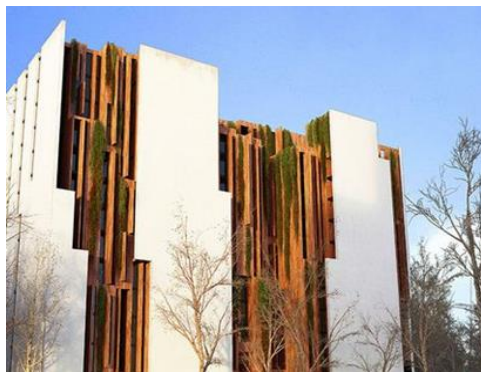
شکل ۳۴- مجتمع مسکونی شار
