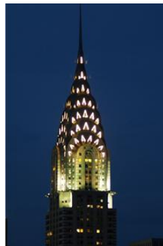
شکل ۱. ساختمان کرایسلر در نیویورک (منبع: Curtis, 1996)
