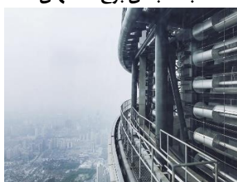
شکل ۱۰: نصب ۲۷۰ توربین بادی محور افقی در بالاترین قسمت نمای برج
