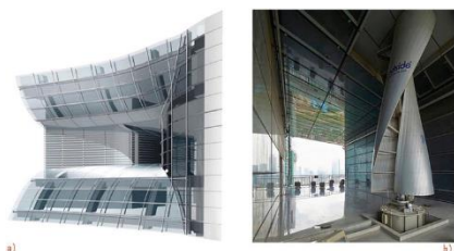
شکل ۷: شکل آیرودینامیکی در نما (a) و نمای دقیق توربین بادی محور عمودی مارپیچ شکل (b)
