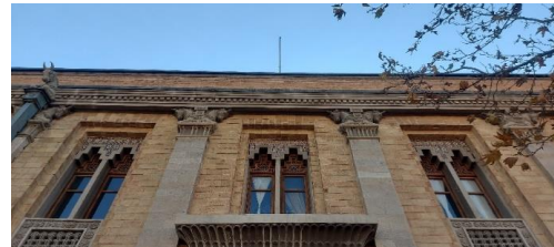
شکل ۶- تزئینات پنجره و قطاربندی ساختمان شهرداری
