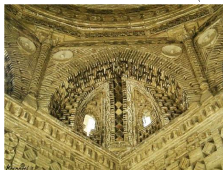
شکل ۱- گوشه‌سازی در گنبد امیراسماعیل سامانی بصورت تویزه لب بند با لنگه طاق پشتی به همراه دو تاسه اجرای در دوطرف آن می‌باشد.
