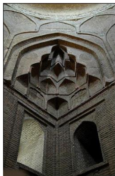
شکل ۱۴- منطقه انتقال با قرار دادن منشورشانزده پهلو بر روی زمینه هشت ضلعی درمسجد گلپایگان تکمیل می‌شود.
