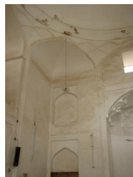
شکل ۲۱- گوشه سازی گنبد مسجد جامع اردکان بصورت اسکنج ساده با کاربندی بین آن ها
