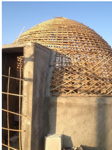
شکل ۱۰- آدوربند با دیوار بتنی (بلوک)، تلفیق مصالح سنتی و جدید در منطقه کوهستانی در دسک، جبالبارز جیرفت، (عکاس: صحت منش ۹۷/۰۴/۲۸)
