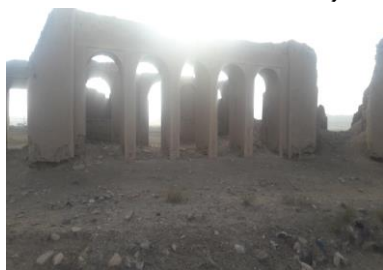
تصویر (۶) آسیب پاکار به دلیل عدم وجود ازاره
