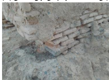
تصویر (۶) آسیب پاکار به دلیل عدم وجود ازاره
