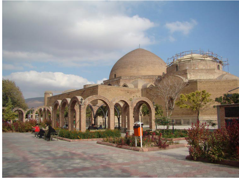
شکل (۲) مسجد کبود تبریز
