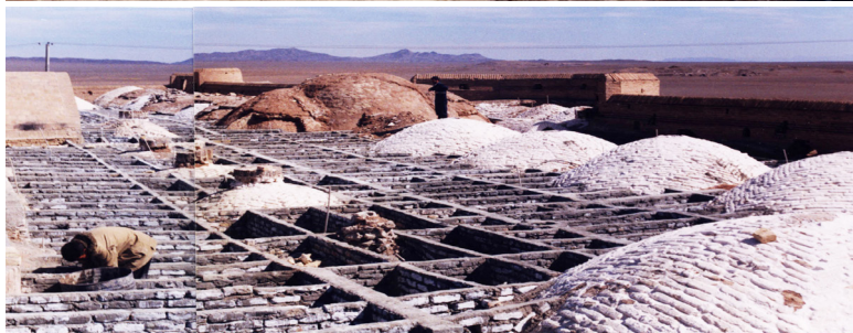
شکل ۱۳: پنام کاری سقف کاروانسرا و مسطح نمودن بام توسط مجوف کردن آن، بام کاروانسرای میاندشت، سمنان (مأخذ: میراث استان سمنان)
