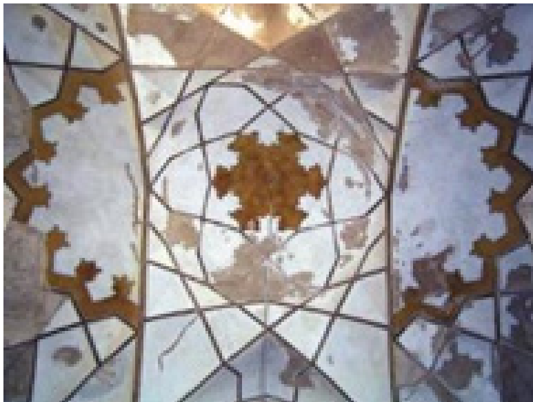
تصویری از کاربندی الحاقی گنبدخانه مدرسه شمسیه مأخذ: پایگاه میراث فرهنگی یزد
