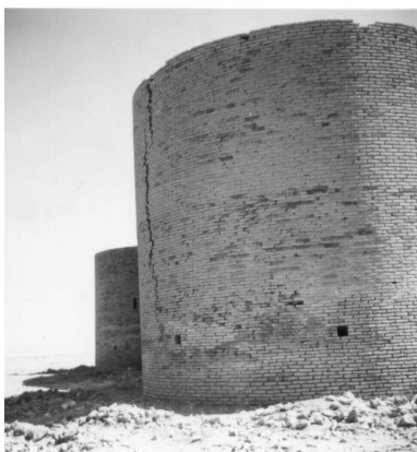
شکل ۹: استفاده از خشت و آجر در جرز و تاق‌های کاروانسرا، راست: رباط زین الدین، یزد / چپ: رباط بیاض، کرمان (مأخذ: نگارندگان)
