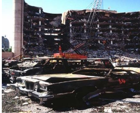
شکل (۱): تخریب ساختمان آلفرد پی مورا (اسکویی و فرهادی پور، ۱۳۹۸)
