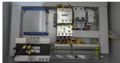
شکل ۱۱- سیم کشی تابلو کنترل جدید
