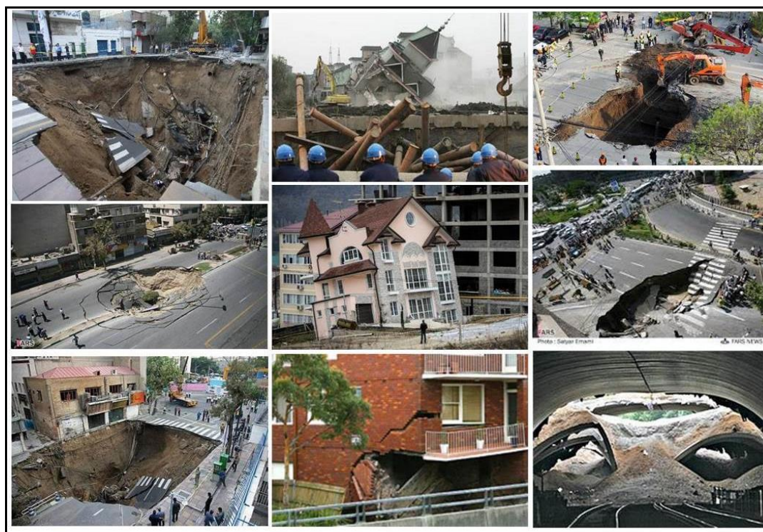
شکل ۱ - تصویری از ریزش‌ها و خرابی‌ها در برخی از پروژه‌های تونل‌های شهری
