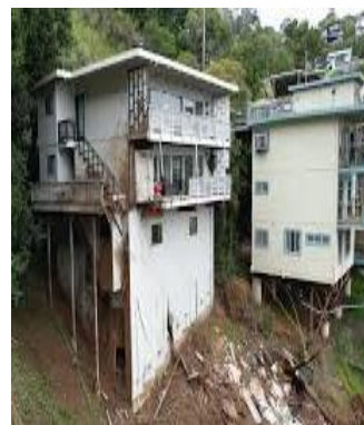
شکل ۱. نمونه‌هایی از فروریزش سازه‌های احداث‌شده بر روی شیروانی.
