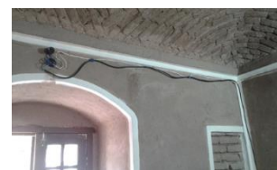
تصویر ۱۱- برق کشی روکار بدون داکت تاسیسات
