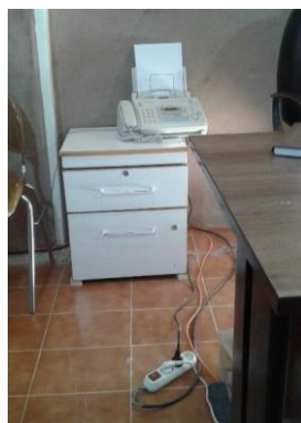
تصویر ۲۰- استفاده از چند راهی برق
