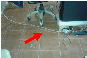
تصویر ۸- نامرتب بودن کابل‌های رایانه
