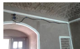
تصویر ۱۱- برق کشی روکار بدون داکت تاسیسات
