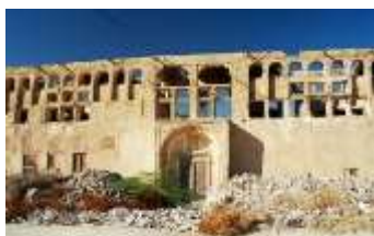
تصویر ۹: خانه بهزاد، محله مساح در بندر لنگه (قاجاریه). در این خانه ۱۴۰ ساله دارای حیاط مرکزی نیمه درون‌گرا و مصالح مورد استفاده در دیوارها از سنگ است و طاق مسطح دارد (سعادت، کریمی‌نژاد و پورعلیخانی، ۱۳۹۴).
