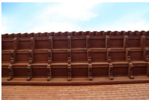
شکل ۱۸: چوب‌کاری حاشیه سقف، سه سرشیر سقف موزه. منبع: نگارنده، ۱۳۹۶.
