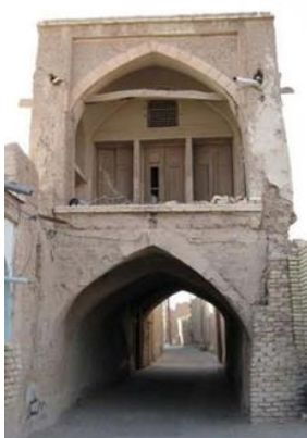
تصویر ۱۰- نمای دو ساباط در بافت تاریخی نایین ساخته شده با مصالح بومی منطقه خشت و ملات گل ((نگارنده))
