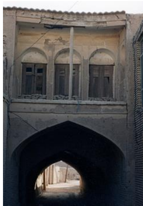
تصویر ۱۰- نمای دو ساباط در بافت تاریخی نایین ساخته شده با مصالح بومی منطقه خشت و ملات گل ((نگارنده))
