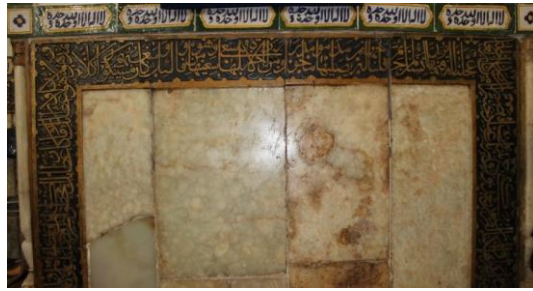
تصویر ۴. نمونه‌ای از بخش مرمت شده به صورت تخت و کتیبه‌های به خط ثلث دور آن. ماخذ: نگارندگان
