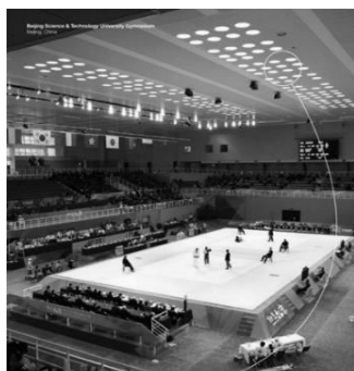
شکل ۱۹- اجرای لوله نوری در ورزشگاه دانشگاه علم و تکنولوژی پکن
