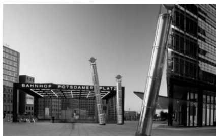
شکل ۴- لوله منشوری توخالی نصب شده در برلین آلمان برای ورود نور خورشید به مترو
