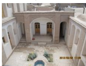
شکل ۱۵- بعد از مرمت آجرفرش و باغچه (مأخذ: نگارنده)
