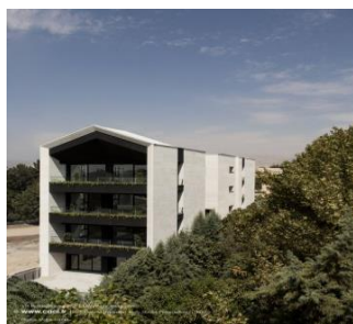
شکل ۳- آپارتمان مسکونی ۱۰۶ منبع: http://www.caoi.ir
