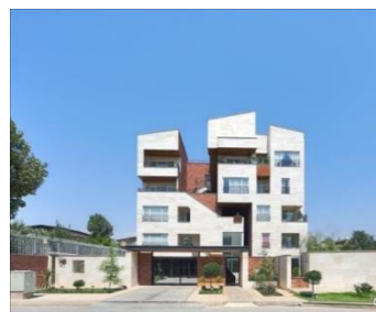
شکل ۱- آپارتمان مسکونی ۲۱۰ منبع: http://www.caoi.ir
