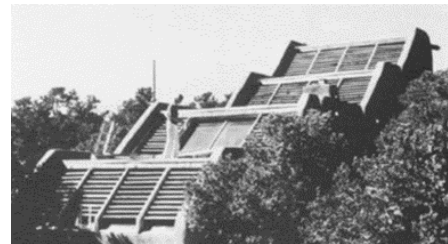
تصویر شماره ۹ بامهای شیبدار جهت نصب آبگرمکن خورشیدی
