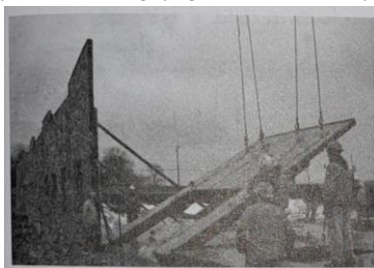
شکل ۱۹- نحوه اجرای سیستم برافراشتن از روی زمین (فرزانی و همکاران، ۱۳۹۷)
