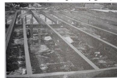
شکل ۹- سیستم کف کاذب (قاسم زاده، ۱۳۹۴)
