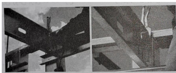
شکل ۱۸- سیستم اجرای مونتاژ در محل (فرزانی و همکاران، ۱۳۹۷)
