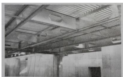
شکل ۱۵- اجرای سقف در سیستم قاب فولادی سبک نورد سرد(فرزانی و همکاران، ۱۳۹۷)
