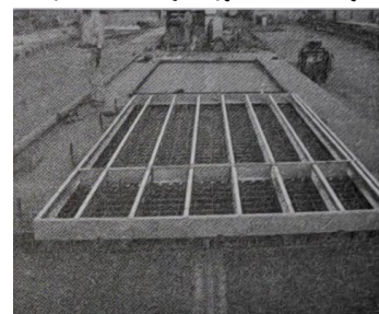
شکل ۱۰- قراردادن سازه کف بر روی شبکه میلگرد کف (قاسم زاده، ۱۳۹۴)
