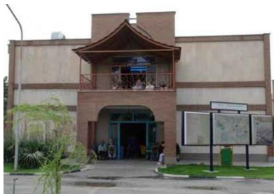
تصویر ۲: ورودی آسایشگاه کهریزک
