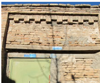
شکل شماره (۷): فرسودگی مصالح و ملات‌ها
