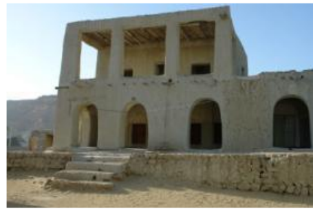
شکل ۵- نمای جنوبی (منبع: میراث فرهنگی)
