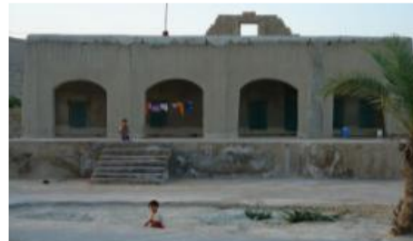
شکل ۴-۳-۱- نمای جنوبی، منبع: میراث فرهنگی
