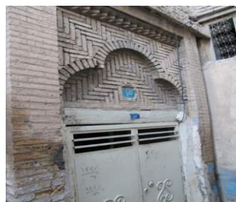
شکل شماره (۶): غیر همگون بودن مصالح بکار رفته در بنا
