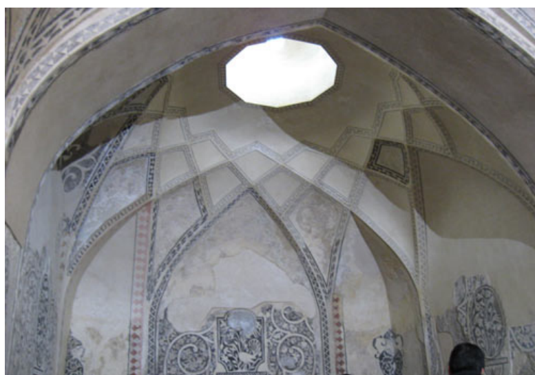
شکل ۱۱. کاربندی حمام (عکس از نگارنده)
