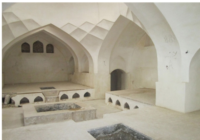
شکل ۱۳. آهکبری حمام (عکس از نگارنده)
