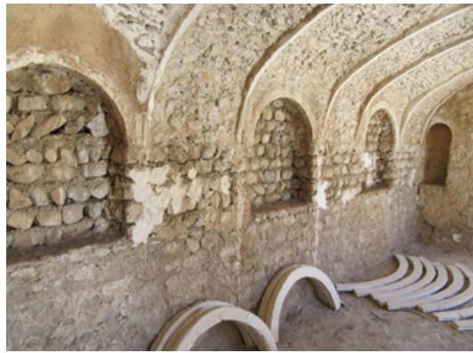
اجرای دیوار سنگی در تاقچه‌ها بدون اتصال هشت و گبر
