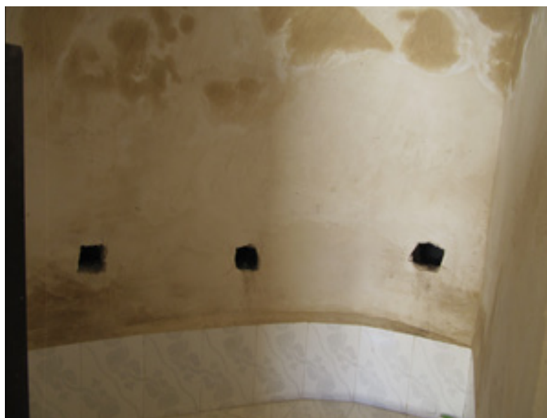
اتصال بیواسطه کاشی به دیوار اصلی بنا
