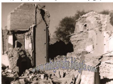
ایوان مسجد جامع پایین کاخک بعد از زلزله خرابی و شکست کامل به جز جرز آن
