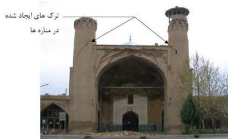
شکل شماره ۲۷ و ۲۸ - نمایی از ایوان جنوبی مسجد جامع بروجرد و جدانشدگی نیم گنبد از ایوان (مقاله زلزله سییلاخور)
