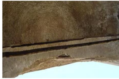
شکل شماره ۲۷ و ۲۸ - نمایی از ایوان جنوبی مسجد جامع بروجرد و جدانشدگی نیم گنبد از ایوان (مقاله زلزله سییلاخور)
