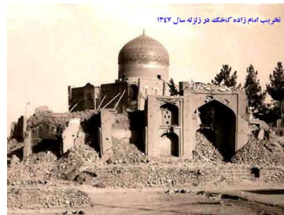
سر در ورودی امام زاده کاخک خرابی خارج از صفحه سقف ایوان و ایجاد ترک های برشی
