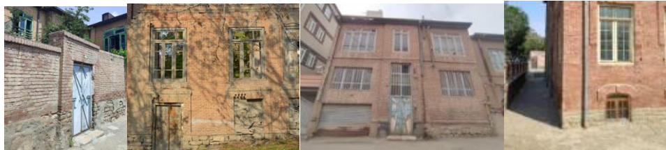
شکل ۳- پاخور سنگی دیوارهای خارجی (ماخذ: نگارندگان)
