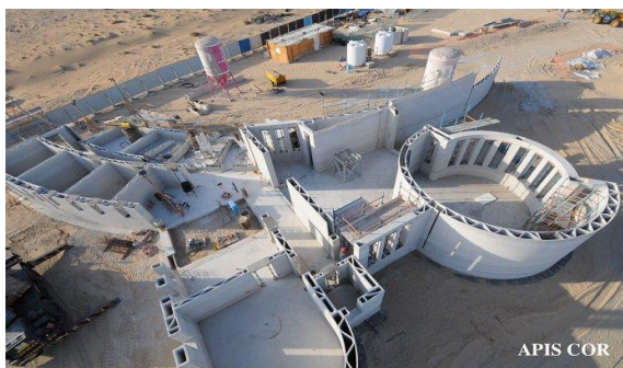
شکل ۴- سازه اداری شرکت آپیس کور دوبی (ساختمانچی، پرینترهای سه بعدی)
