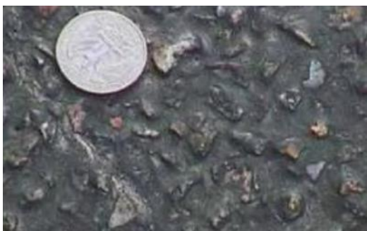
تصویر ۱۶: عیوب سطحی روسازی آسفالت معابر شهری (قیر زدگی)، بزرگنمایی با نمایش سکه، مأخذ: FHWA, 2003
