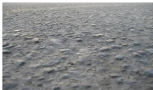
تصویر ۱۷: عيوب سطحی روسازی آسفالت معابر شهری (شن زدگی و هوازدگی)، مأخذ: سید محمودی و شهری، ۱۳۹۶: ۱۱۲
