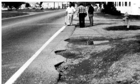
تصویر ۹: ترک خوردگی لبه با شدت زیاد، مأخذ: ASTM D6433. 2007
