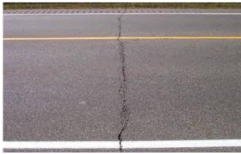
تصویر ۸: خرابی های روسازی آسفالت معابر شهری در ترک های عرضی، مأخذ: Office of Materials and Road Research. 2011
