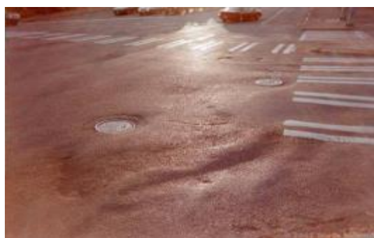
تصویر ۱۳: خرابی های روسازی آسفالت معابر شهری در موج و چین زدگی، مأخذ: ASTM D6433. 2007
