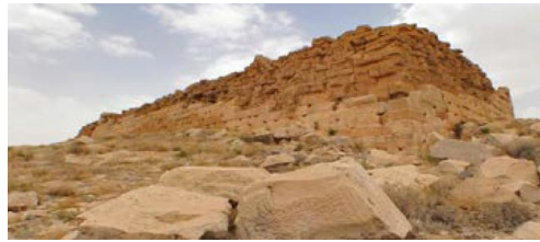
تصویر شماره ۲: صفا تل تخت پاسارگاد و کاربرد سنگ‌های پاک تراش در بدنه آن (مأخذ: GoogleEarth)
